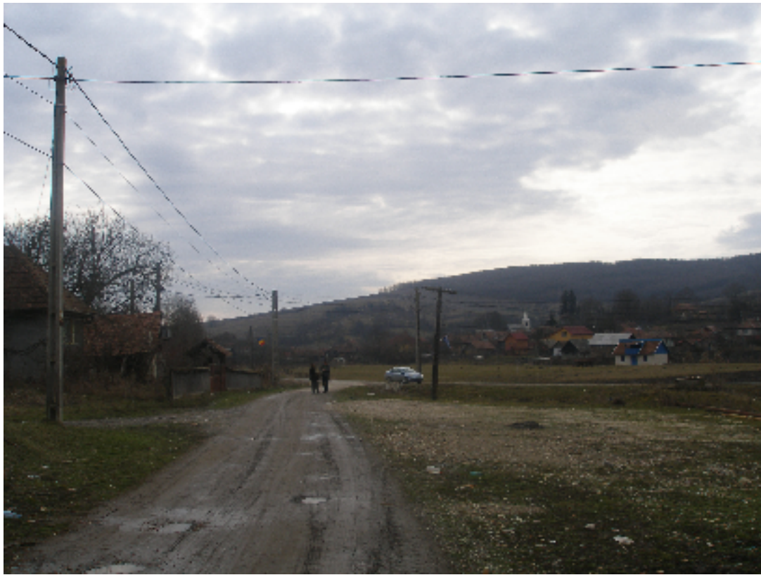
Foto 1. Rețea electrică cu fascicule torsadate și corpuri inexistente
