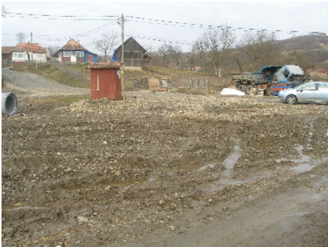
Foto 2. Rețea electrică cu fascicule torsadate și corp de iluminat clasic
